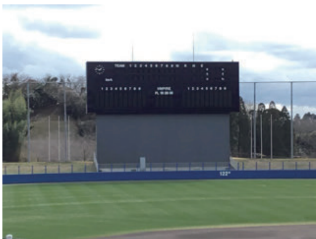
長生の森公園（スコアボード改修）
