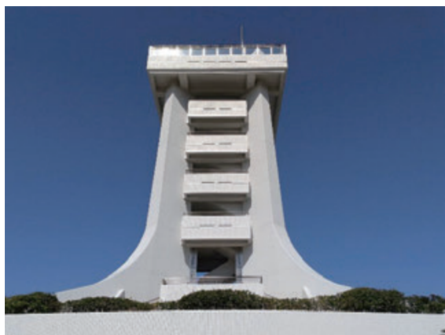
蓮沼海浜公園（展望塔の外壁更新）
