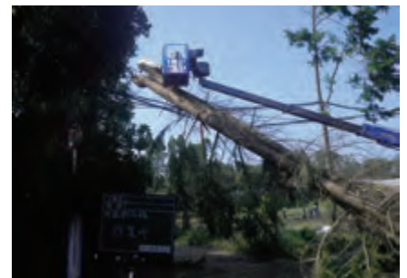
市原市内市道 作業中
