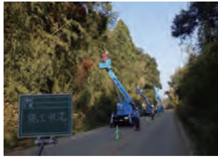
県道千葉茂原線 作業中
