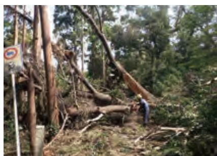
袖ヶ浦市内市道 作業中
