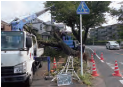
千葉市内街路 作業中
