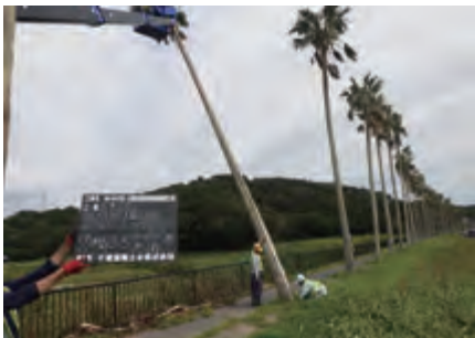
館山市内国道 被災状況
