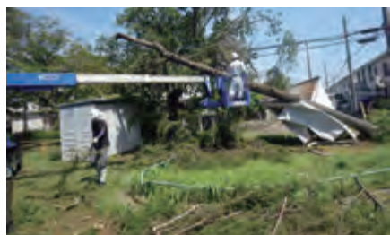
千葉市内公園 作業中
