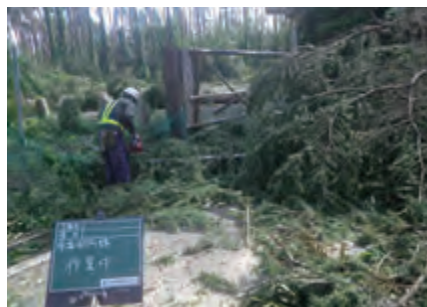
市原市内市道 作業中
