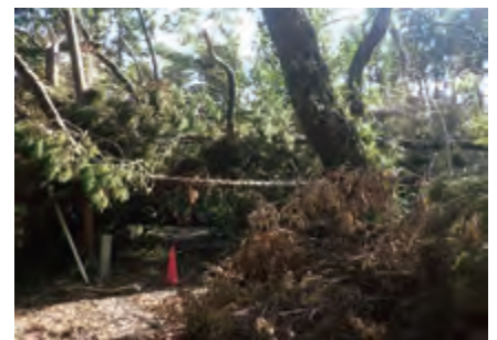
袖ヶ浦市内市道 被災状況
