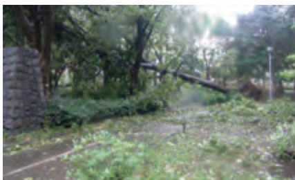
船橋市内県立公園 被災状況
