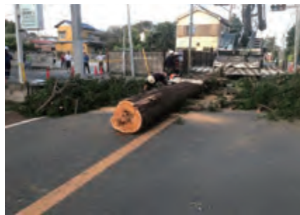
佐倉市内旧国道 作業中
