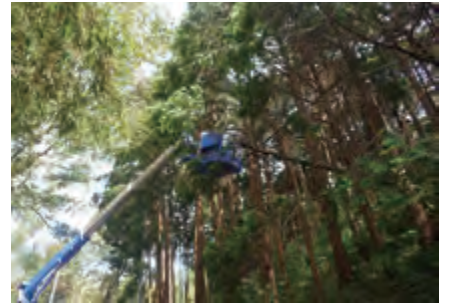
印西市内市道 作業中
