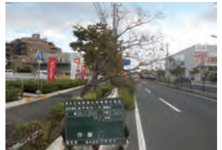
松戸市内街路 被災状況
