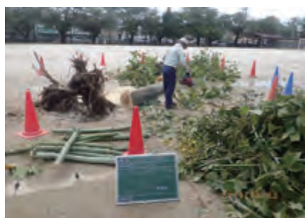
市川市内小学校 作業中
