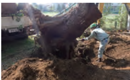
習志野市内公園 作業中
