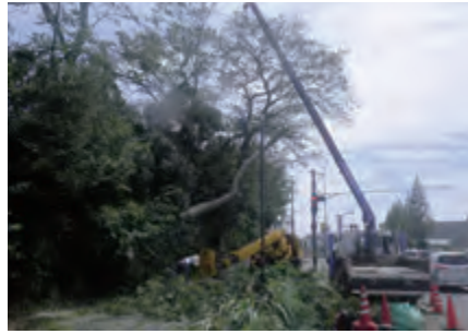
印西市内市道 作業中
