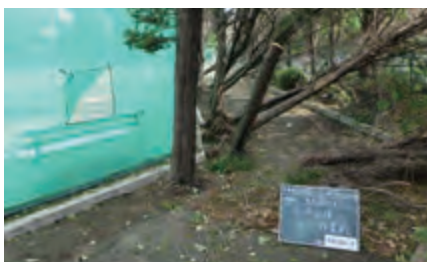
鎌ヶ谷市内公園 被災状況
