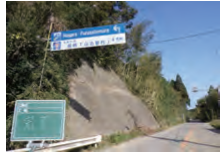
県道千葉茂原線 作業後
