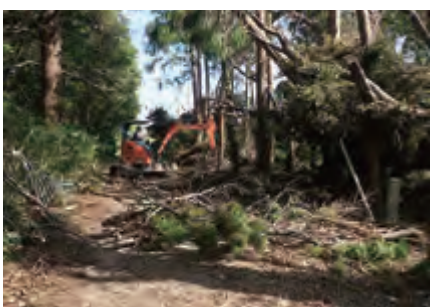
袖ヶ浦市内市道 作業中
