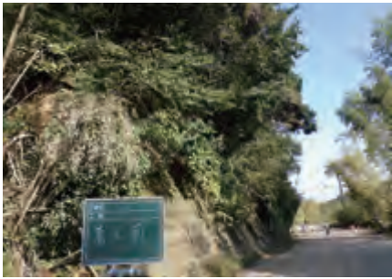
県道千葉茂原線 被災状況
