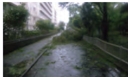
船橋市内県立公園 被災状況
