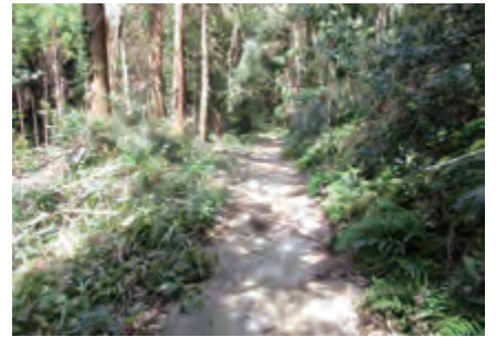
成田市内公道 作業後
