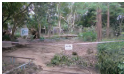
船橋市内県立公園 被災状況
