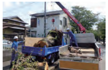
船橋市内街路 作業中
