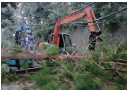
市原市内市道 作業中
