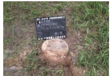
館山市内国道 作業後
