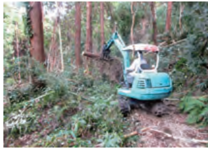
成田市内公道 作業状況
