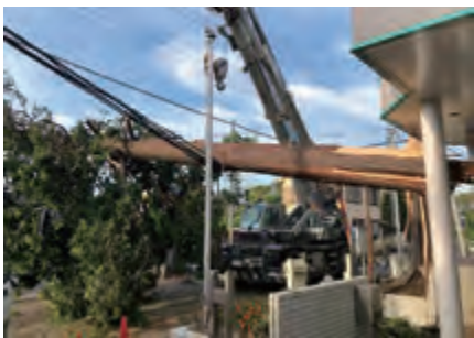
佐倉市内旧国道 作業中
