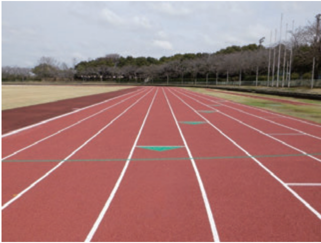
青葉の森公園（陸上競技場走路改修）
