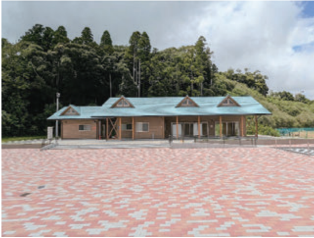
長生の森公園（管理棟建築工事）
