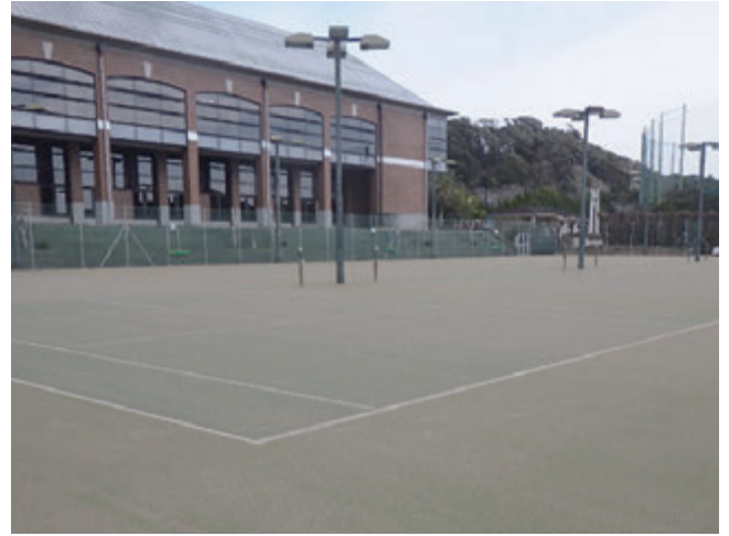
館山運動公園（テニスコート改修工）
